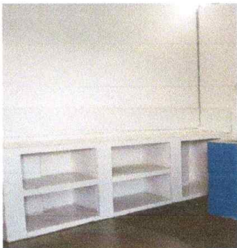
Suministro de materiales y mano de obra para la sustitución de mesa de trabajo de concreto.
