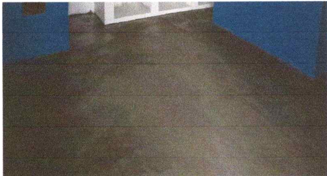
Sustitución de piso firme de concreto, acabado liso color natural en cocina.
