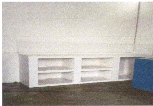
Sustitución de azulejo blanco en mesa de trabajo.
