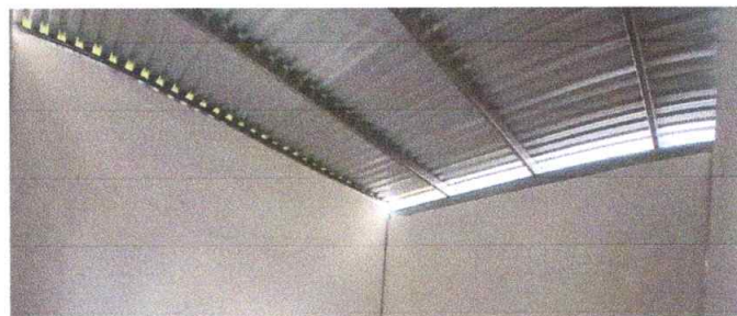
Sustitución de cubierta de lámina
