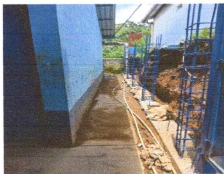
Mantenimiento correctivo de cimiento corrido en muro de contención.
