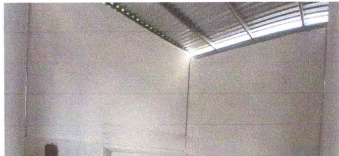
sustitución de paneles prefabricados tipo durock a doble cara en forro de paredes de cocina.
