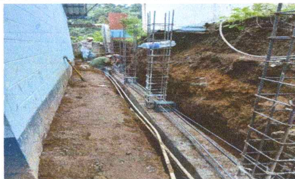
Mantenimiento correctivo de cimiento corrido en muro de contención.
