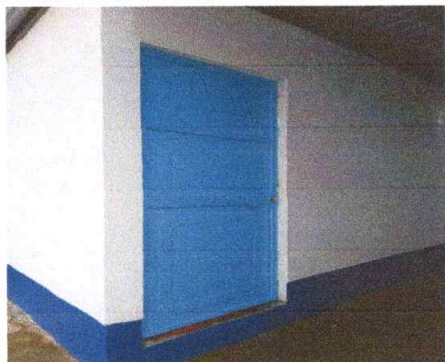
Sustitución de puerta de metal.
