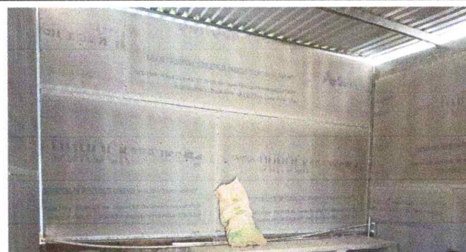
Sustitución de paneles prefabricados tipo durock a doble cara en forro de paredes de cocina.
