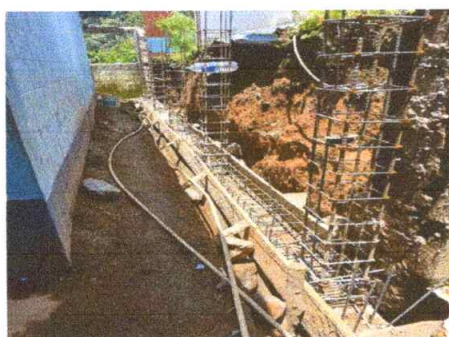
Mantenimiento correctivo de cimiento corrido en muro de contención.
