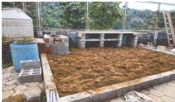
Sustitución de piso firme de concreto, acabado liso color natural en cocina.
