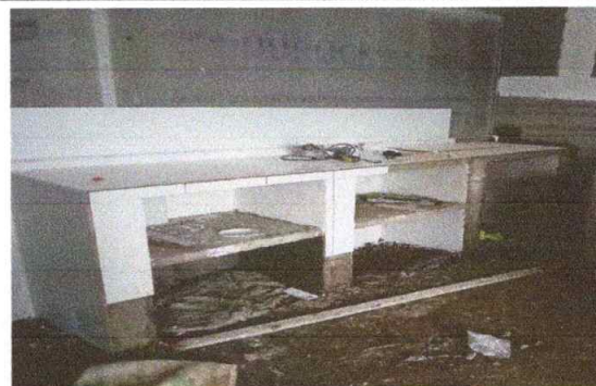
Sustitución de azulejo blanco en mesa de trabajo.
