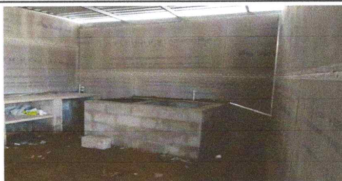
Sustitución de pila en cocina.
