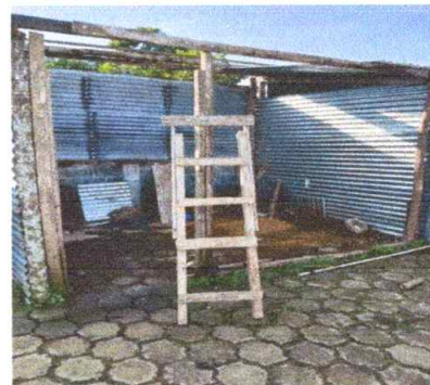
sustitución de cubierta de lámina.
