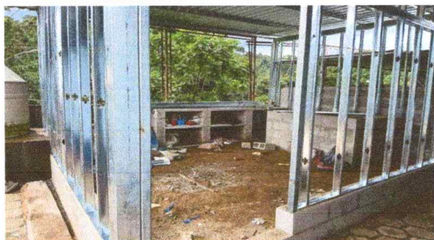
sustitución de cubierta de estructura de lámina
