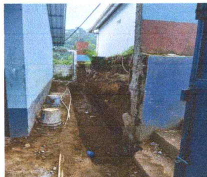
Mantenimiento correctivo de cimiento corrido en muro de contención.
