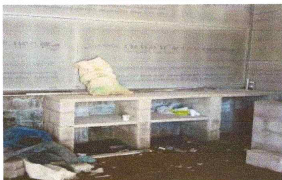
Suministro de materiales y mano de obra para la sustitución de mesa de trabajo de concreto.
