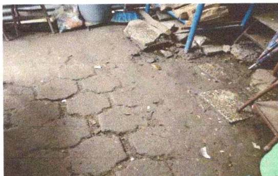
Sustitución de piso firme de concreto , acabado liso color natural en cocina.
