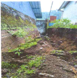
Sustitución de cimientos de concreto en muro colapsado.
