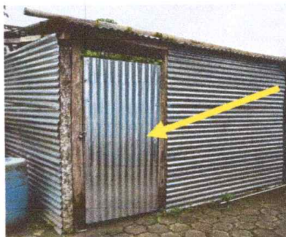
Sustitución de puerta de metal.
