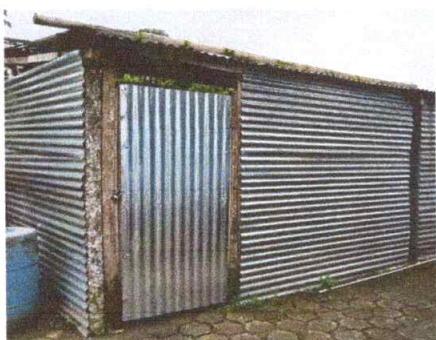
Sustitución de cubierta de estructura metálica.
