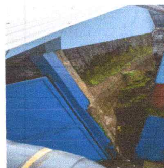
Sustitución de cimientos de concreto en muro colapsado.
