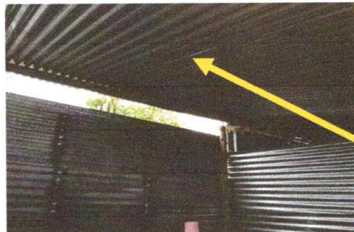
Sustitución de cubierta de lámina.
