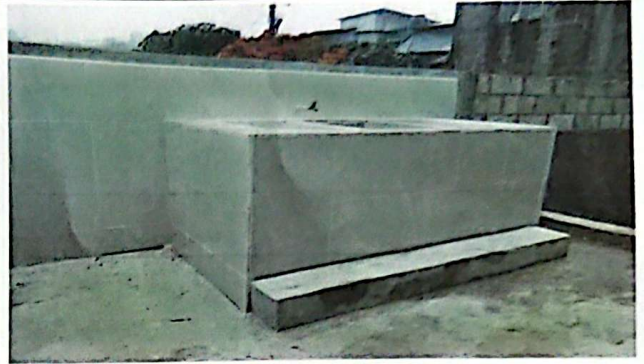
Suministro de materiales y mano de obra para el mantenimiento de pila de 1.30x2.00 Consistente de 8m 2 en azulejado, tallado de 2 mts lineales con cemento y sustitución de tubería de agua potable y drenaje
