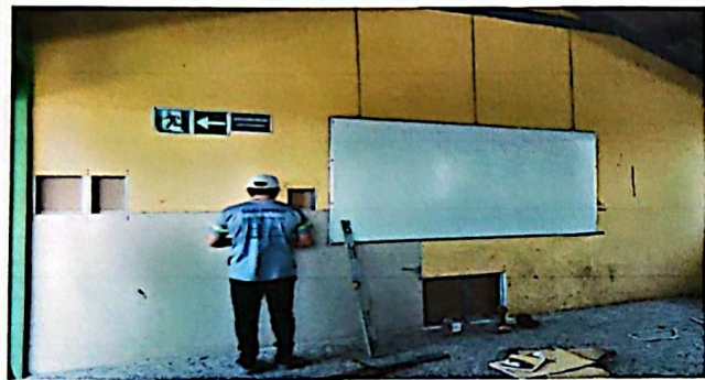
Suministro de materiales y mano de obra para el mantenimiento de paredes De tabla yeso de 80mt 2 Consistente en reparación de agujeros, sustitución de planchas dañadas, resaneo y pintura.
