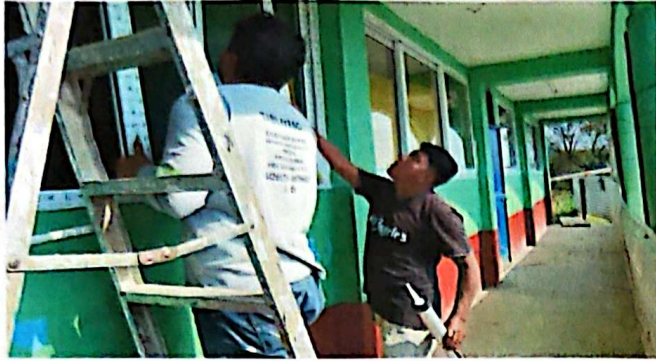
Suministro de materiales y mano de obra para la sustitución de 24 ventana de pvc color Blanco con vidrio transparente de 5mm corredisa de ambos lados
