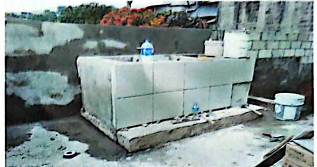
Suministro de materiales y mano de obra para el mantenimiento de pila de 1.30x2.00 Consistente de 8m 2 en azulejado, tallado de 2 mts lineales con cemento y sustitución de tubería de agua potable y drenaje
