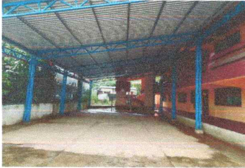
Foto1: SUSTITUCIÓN DE CUBIERTA METÁLICA
