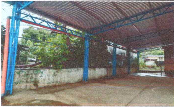
Foto 3: SUSTITUCION DE CANAL PLUVIAL + BAJADA PLUVIAL
