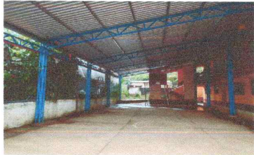
Foto 2: SUSTITUCIÓN DE ESTRUCTURA PORTANTE POR ESTRUCTURA METÁLICA
