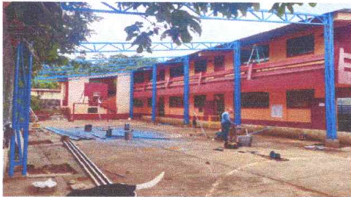
Foto 3: SUSTITUCIÓN DE CANAL PLUVIAL+BAJADAS PLUVIALES
