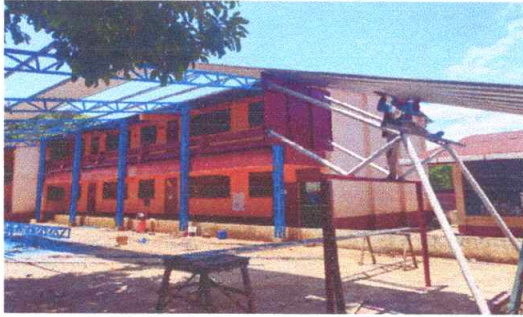
Foto1: SUSTITUCIÓN DE CUBIERTA METÁLICA
