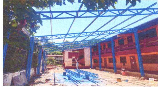
Foto 2: SUSTITUCIÓN DE ESTRUCTURA PORTANTE POR ESTRUCTURA METÁLICA
