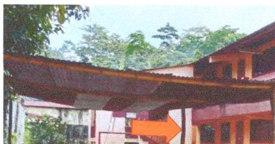
No.2 SUSTITUCIÓN DE ESTRUCTURA PORTANTE POR ESTRUCTURA METALICA
