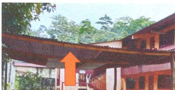
No1. SUSTITUCIÓN DE CUBIERTA METALICA
