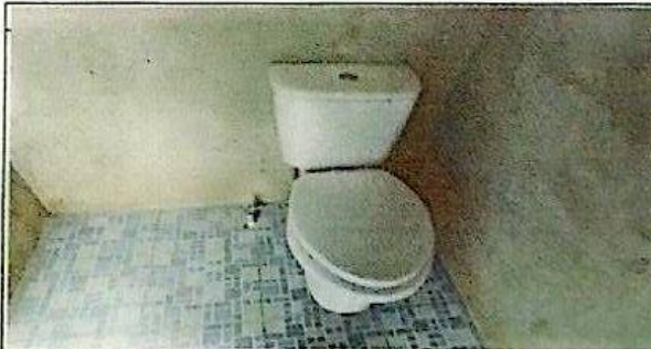
Sustitución de inodoros en sanitarios
