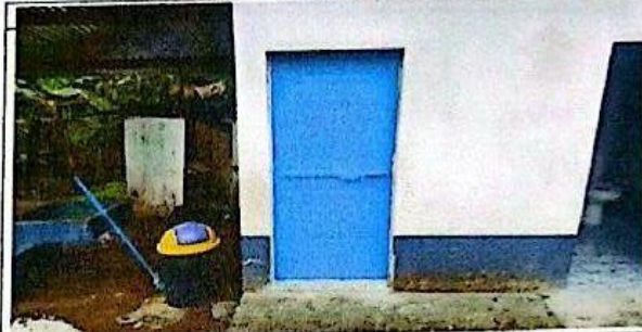
Sustitución de puerta metálica en aulas
