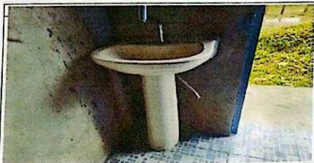
Sustitución de accesorios para lavamanos + grifo monocromado + kit de drenaje
