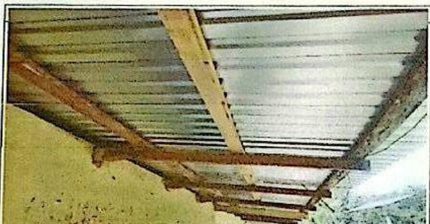
Sustitución de estructura de madera en cublerta
