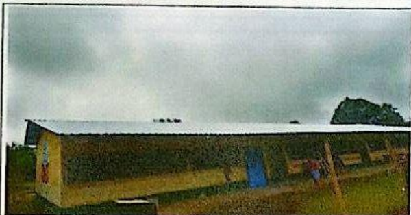
Sustitución de lámina por lámina troquelada cal.28
