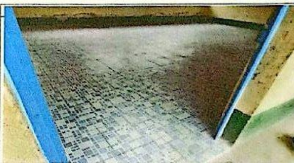
Sustitución de piso de concreto por piso cerámico antideslizante en aulas y baños
