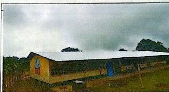
Sustitución de capote de lámina cal.26
