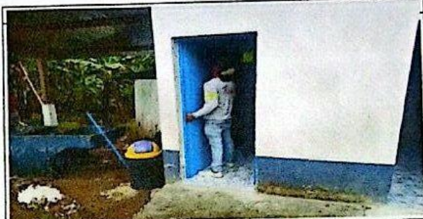
Sustitución de puerta metálica en aulas
