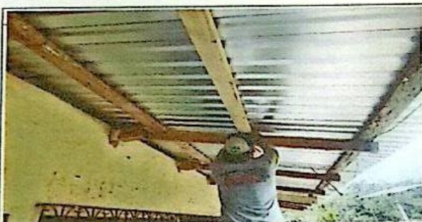
Sustitución de estructura de madera en cubierta
