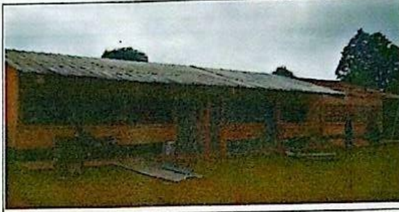
Sustitución de capote de lámina cal.26
