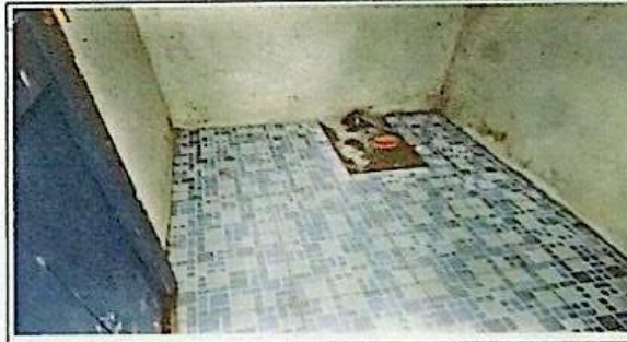
Sustitución de inodoros en sanitarios
