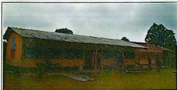
Sustitución de lámina por lámina troquelada cal.26
