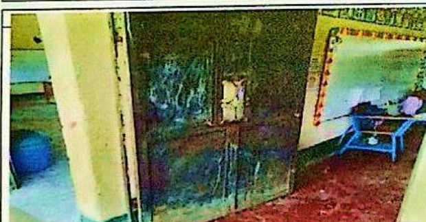
Sustitución de puerta de madera por puerta metálica en baños
