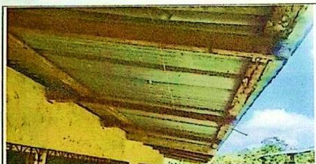
Sustitución de estructura de madera en cubierta
