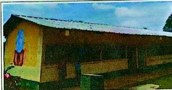
Sustitución de capote de lámina cal.26
