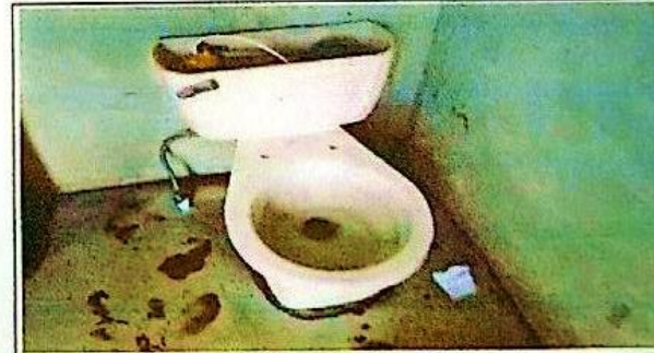
Sustitución de inodoros en sanitarios
