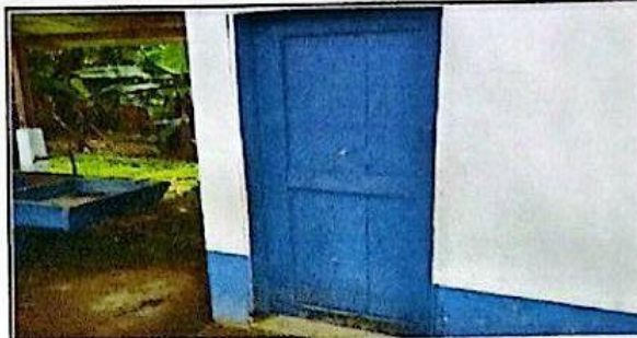
Sustitución de puerta metálica en aulas
