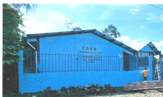
Sustitución de balcones metálicos tipo reja en fachada.
