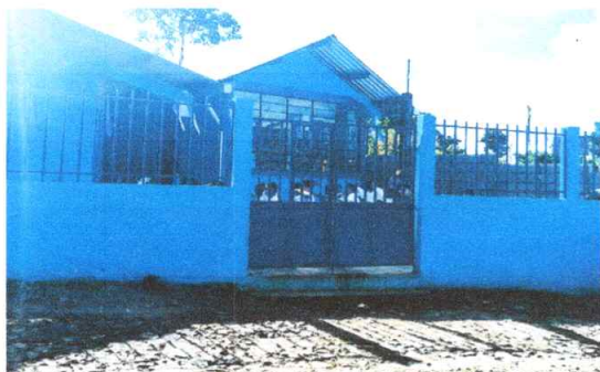
Sustitución de portón metálico en ingreso principal.
