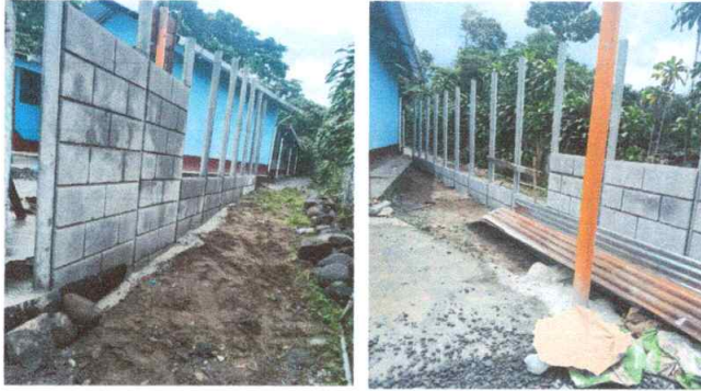
Mantenimiento correctivo y sustitución de muro perimetral prefabricado.
