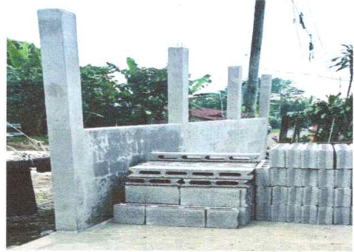
Mantenimiento correctivo de repello y cernido en muros de fachada.
