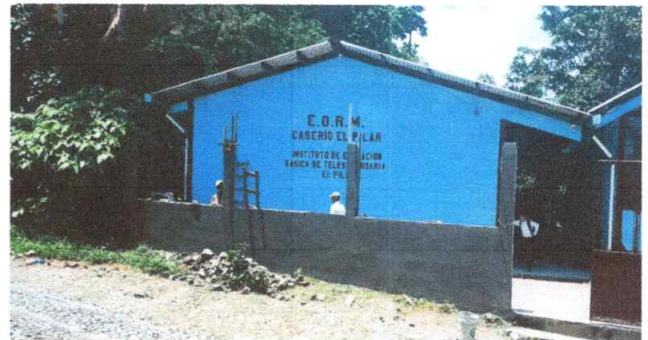
Sustitución de balcones metálicos tipo reja en fachada.
