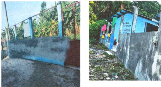
Mantenimiento correctivo de repello y cernido en muros de fachada.
