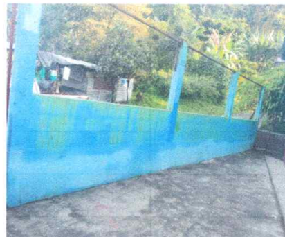
Mantenimiento correctivo de repello y cernido en muros de fachada.
