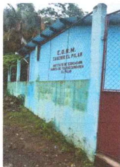
Mantenimiento correctivo de repello y cernido en muros de fachada.
