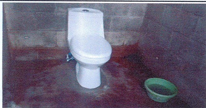
Sustitución de inodoros en servicios sanitarios
