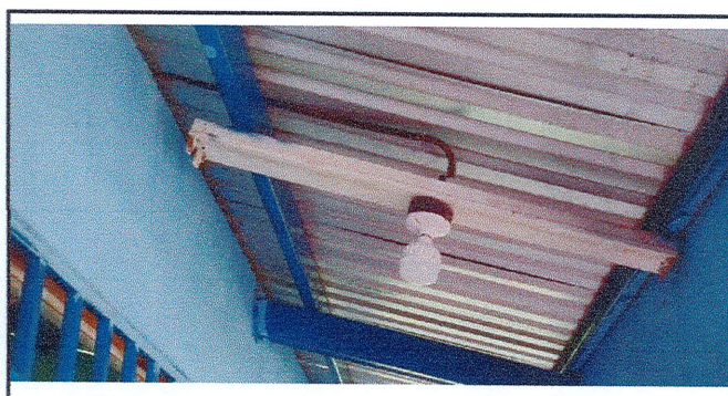
Sustitución de cable electrico en modulos de aulas (sistema de fuerza e iluminación)
