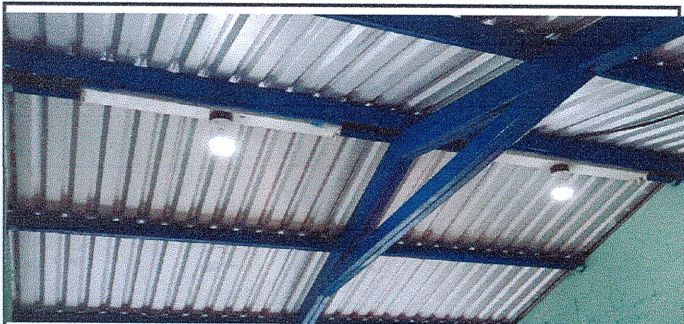
Sustitución de luminaria
