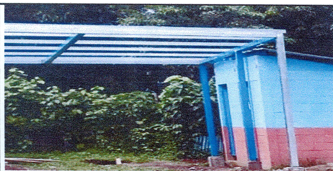
Sustitución de estructura metálica en cubierta
