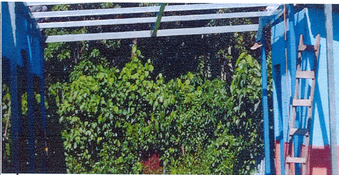
Sustitución de estructura metálica
