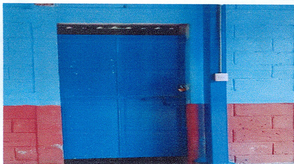
Sustitución de puertas en aulas y santaros
