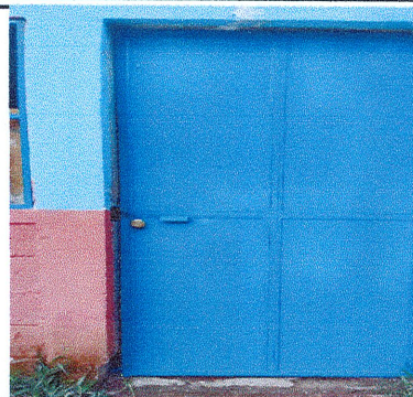
Mantenimiento preventivo de puertas metálicas
