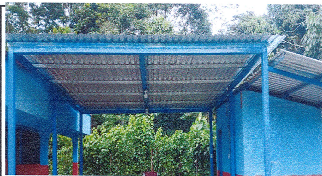
Sustitución de Lámina Troquelada cal. 26 en cubierta
