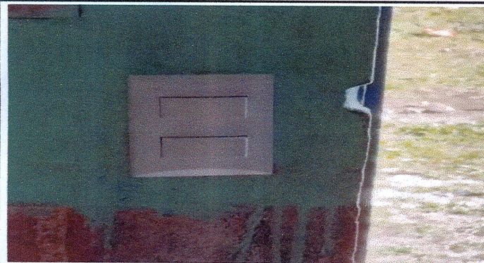
Sustutición de interruptores
