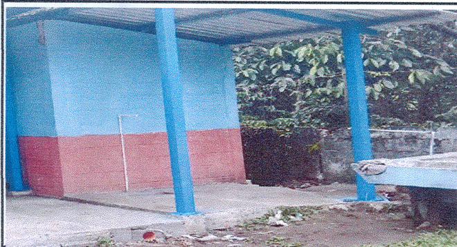
Sustitución de piso de 0.5m
