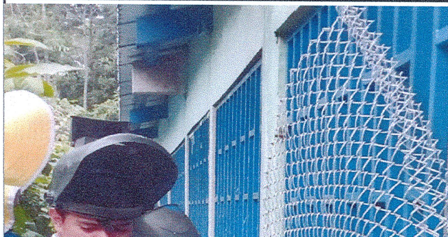
Reparacion de balcon metalico con malla galvanizada
