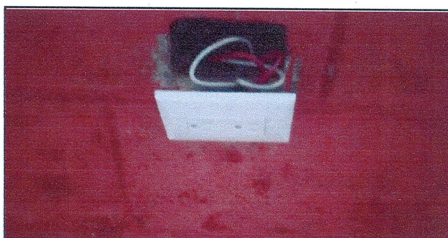
Sustitución de toma corrientes
