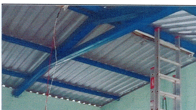
Sustitución de cable electrico en modulo de aulas (sistema de fuerza e iluminación)
