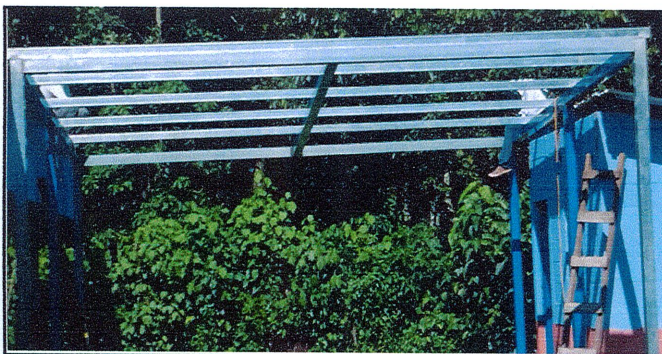
Sustitución de Estructura metálica en cubierta
