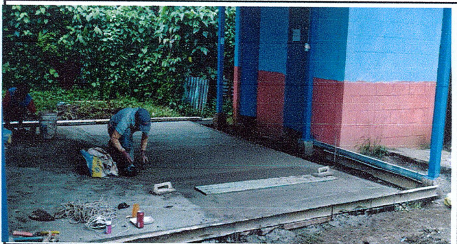
Sustitución de Estructura metálica
