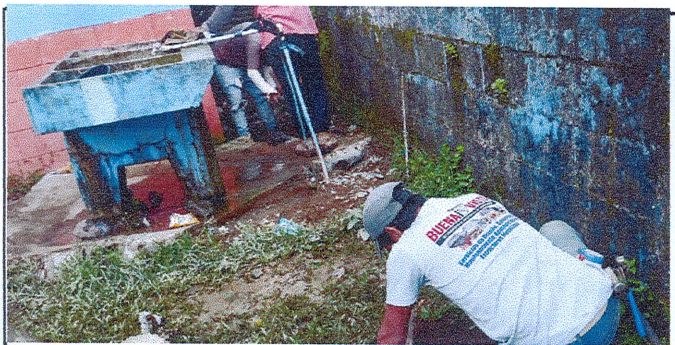
sustitucion de pila de concreto
