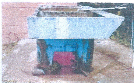
Sustitución de piso de concreto t=0.06m
