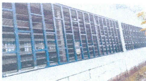
Reparación de balcón metálico con malla galvanizada
