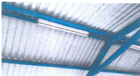
Sustitución de luminarias
