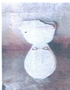
Sustitución de inodoros en servicios sanitarios
