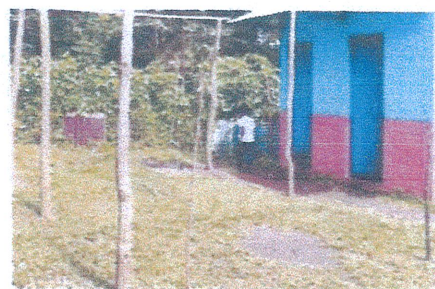
Sustitución de estructura metálica
