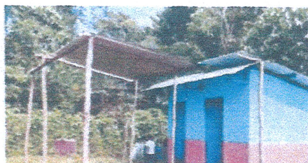
Sustitución de estructura metálica en cubierta
