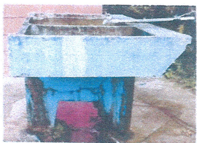
Sustitución de pila de concreto
