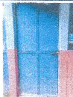
Mantenimiento preventivo de puertas metálicas
