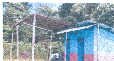
Sustitución de lámina troquelada cal.26 en cubierta
