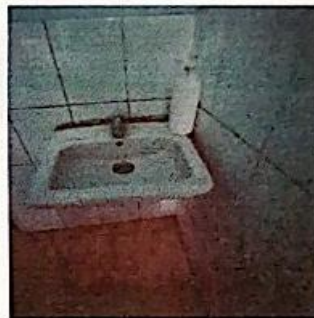
Foto 8: Mantenimiento a lavamanos y tazas sanitarias
