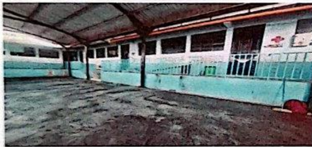
Foto 3: Reparación de torta de concreto más acabado gris alizado
