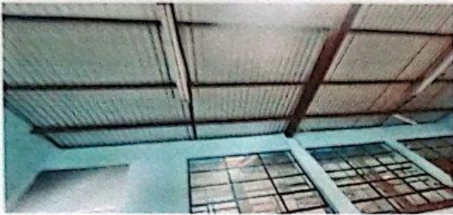
Foto1: Sustitución de cubierta metalica con lamina acanalada calibre 25 metalico
