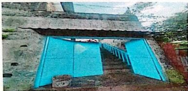
Foto 7 : Mantenimiento a porton principal mas techo de proteccion
