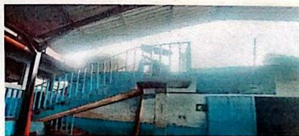
Foto 12: Sustitucion de barandal
