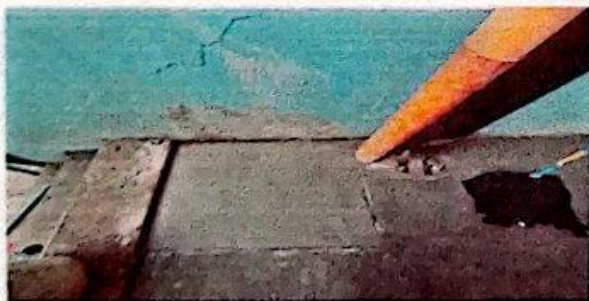
Foto 5: Reparación de caja de registro más sustitución de tubo de desfogue pluvial
