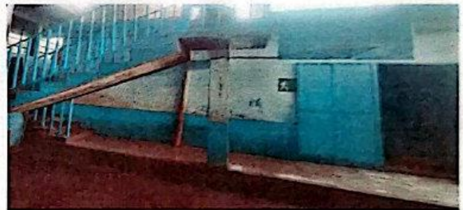
Foto 4: Reparación de banqueta de servicios sanitarios
