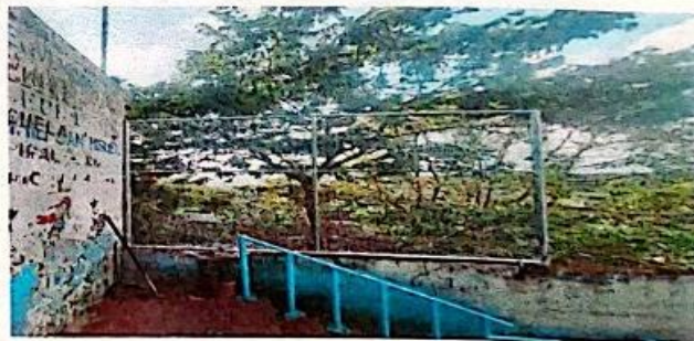
Foto 10: Sustitucion de maya perimetral
