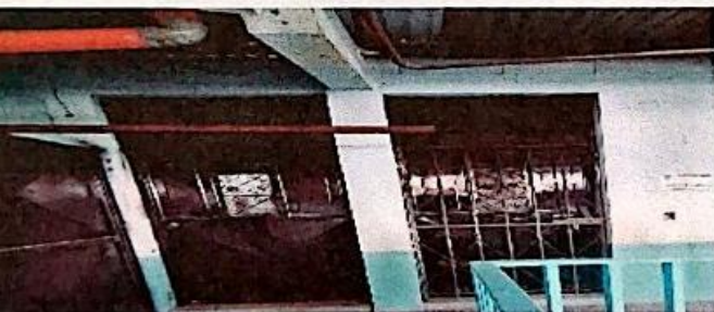
Foto 9: Mantenimiento y sustitución de chapas a puertas
