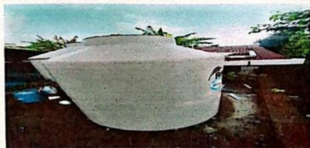
Foto 11: Sustitucion de rotoplas capacidad 1500 ts.
