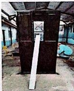
Foto 9: Mantenimiento y sustitución de chapas a puertas
