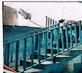
Foto 12: Sustitución de barandal
