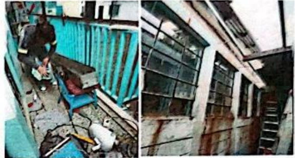
Foto 2: Sustitución de canal pluvial y bajadas de agua pluvial.
