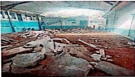
Foto 3: reparación de torta de concreto más acabado gris alisado
