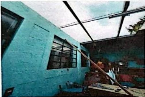
Foto1: Sustitución de cubierta metalica con lamina acanalada calibre 26 metalico
