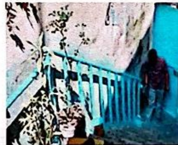
Foto 6: Reparación y mantenimiento de baranda
