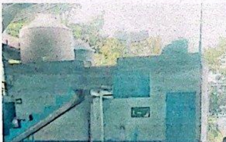
Foto 11: Sustitución de rotoplas capacidad 1500 ts.
