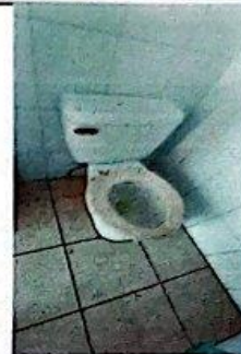
Foto 8: Mantenimiento a lavamanos y tazas sanitarias
