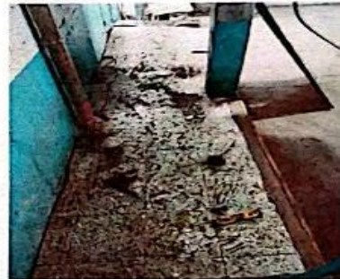
Foto 4: Reparación de banqueta de servicios sanitarios
