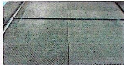
Foto 10: Sustitución de maya perimetral
