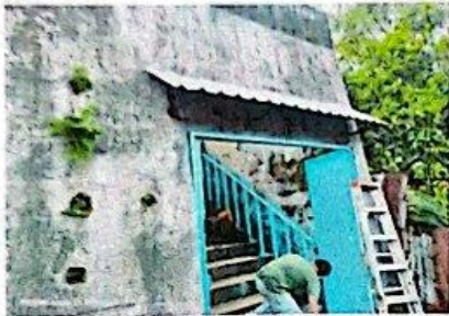
Foto 7: Mantenimiento a porton principal más techo de protección
