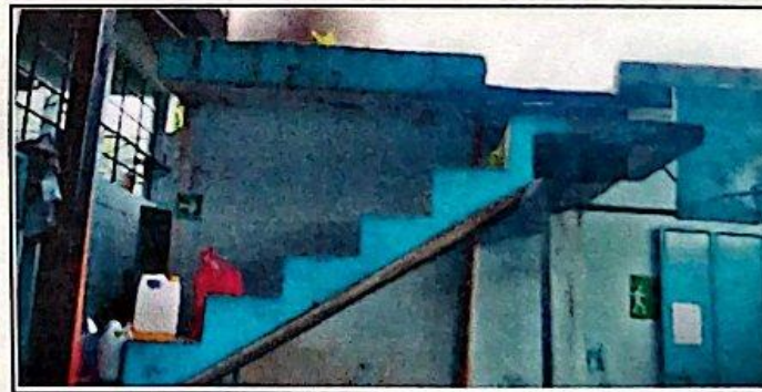
Sustitución de barandal
