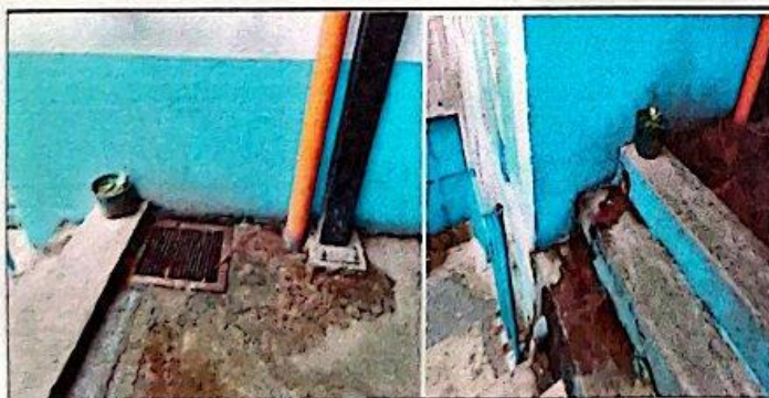
Reparación de caja de registro más sustitución de tubo de desfogue pluvial
