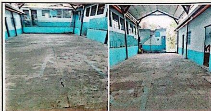
Reparación de torta de concreto más acabado gris alisado
