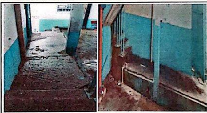
Reparación de banqueta de servicio sanitario
