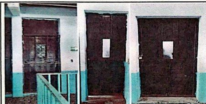
Mantenimiento y sustitución de chapa a puertas
