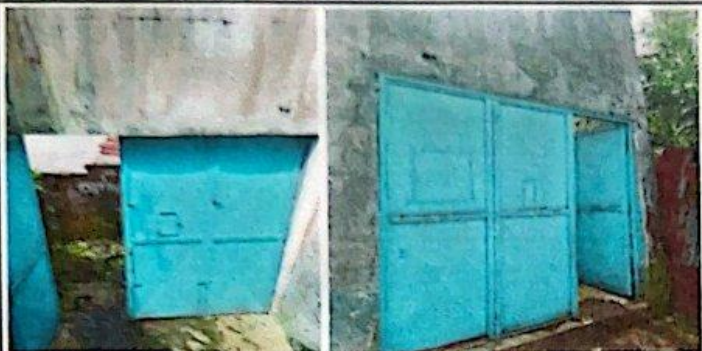
Mantenimiento a porton principal más techo de protección
