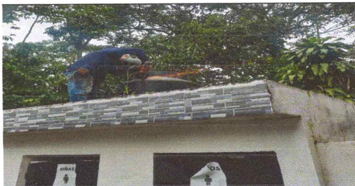
Foto 3: Sustitución de rotoplas capacidad 1,100 Lts.
