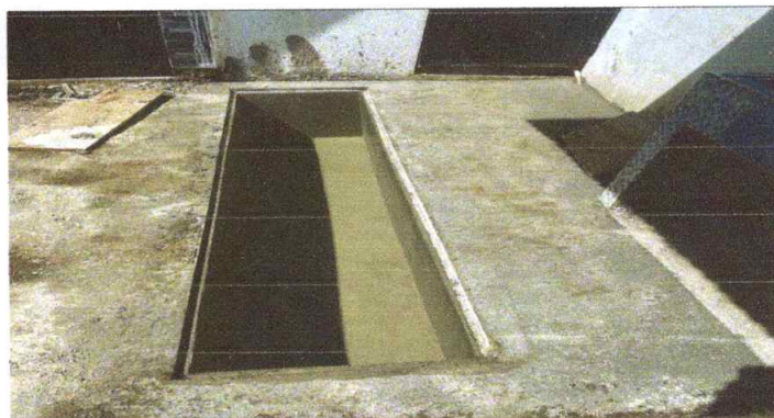
Foto 4: Reparación de cuneta para agua pluvial
