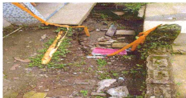
Reparación de cuneta para agua pluvial
