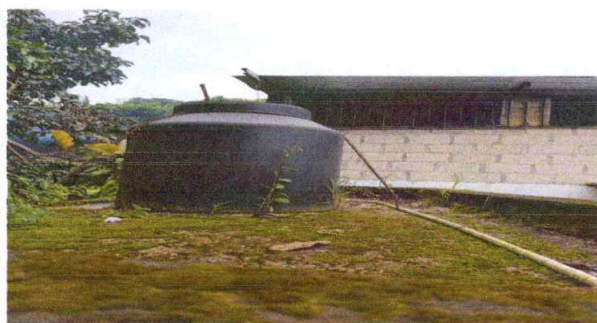
Sustitución de rotoplas capacidad 1,100Lts.
