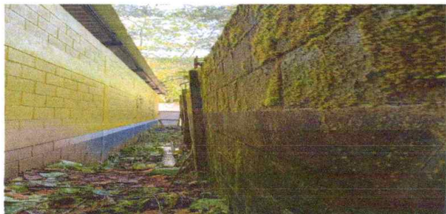
Mantenimiento correctivo de muro de contención
