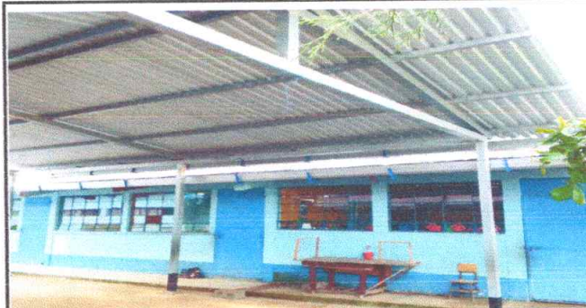
SUSTITUCION DE CANAL PLUVIAL CON LAMINA LISA CALIBRE 26 EN MODULO No. 1 y 2
