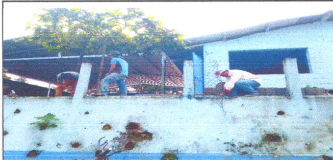
SUSTITUCION EN CERCO DE MAYA Y TUBOS GALVANIZADOS EN MURO PERIMETRAL
