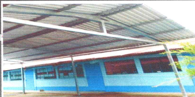
SUSTITUCION DE CANAL PLUVIAL CON LAMINA LISA CALIBRE 26 EN MODULO 1 Y 2
