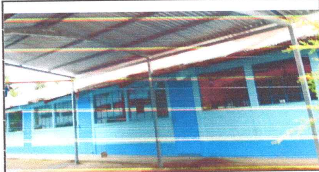
Sustitucion de canal pluvial con lamina lisa calibre 26 en modulo No. 1 Y 2
