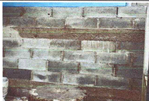
No.4 SUSTITUCION DE MURO PERIMETRAL BLOCK POR BLOCK
