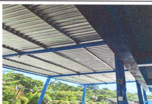
No.2 SUSTITUCION DE ESTRUCTURA PORTANTE POR ESTRUCTURA METALICA
