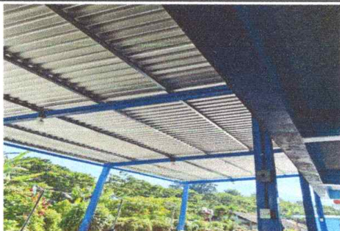
No1. SUSTITUCION DE CUBIERTA METALICA
