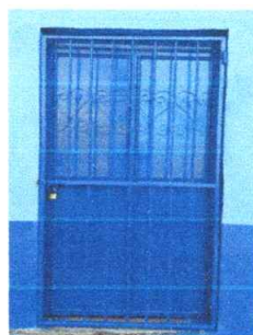
No 6. SUSTITUCIÓN DE BALCÓN METÁLICO DE PUERTA EN COCINA
