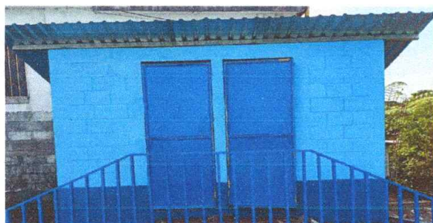
No 9. MANTENIMIENTO APLICACIÓN DE PINTURA EN BODEGA
