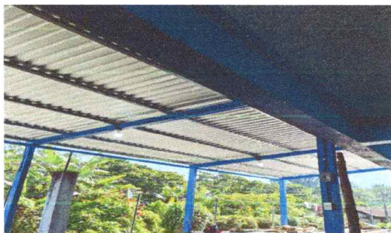
No 3. SUSTITUCION DE ENERGIA ELECTRICA FUERZA E ILUMINACIÓN
