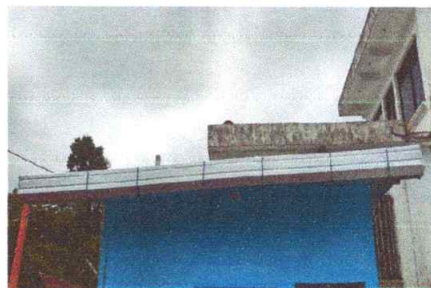
No.8 SUSTITUCIÓN DE CANAL PLUVIAL
