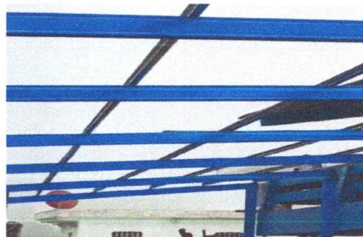
No.2 SUSTITUCION DE ESTRUCTURA PORTANTE POR ESTRUCTURA METALICA
