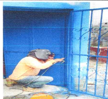
No 6. SUSTITUCIÓN DE BALCÓN METÁLICO DE PUERTA EN COCINA
