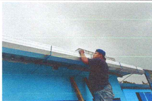
No.8 SUSTITUCIÓN DE CANAL PLUVIAL
