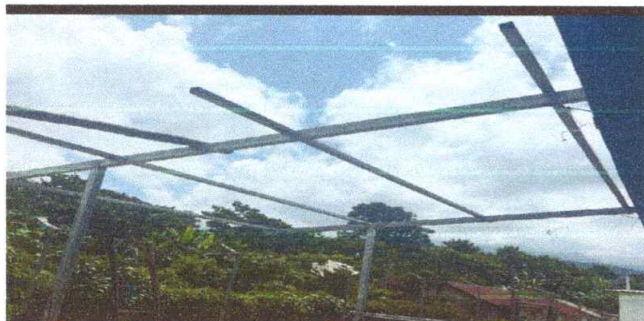
No1. SUSTITUCION DE CUBIERTA METALICA
