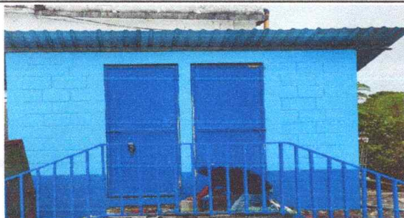
No 9. MANTENIMIENTO APLICACIÓN DE PINTURA EN BODEGA
