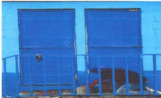
No 7. SUSTITUCIÓN DE PUERTAS DE METAL. EN BODEGA
