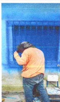
No 5. SUSTITUCIÓN DE BALCÓN METÁLICO DE VENTANA EN COCINA
