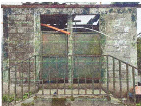
No 9. MANTENIMIENTO APLICACIÓN DE PINTURA EN BODEGA
