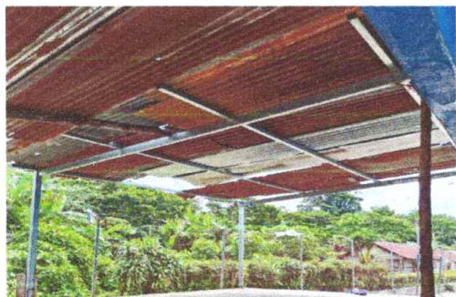
No1. SUSTITUCION DE CUBIERTA METALICA
