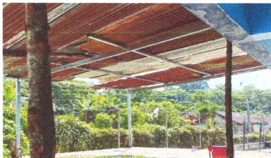
No.2 SUSTITUCION DE ESTRUCTURA PORTANTE POR ESTRUCTURA METALICA
