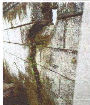
No.4 SUSTITUCION DE MURO PERIMETRAL BLOCK POR BLOCK
