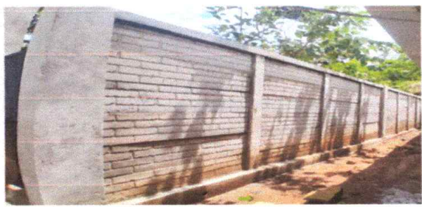
No.5 Mantenimiento correctivo sustitución de circulación de lamina por muro perimetral prefabricado de concreto
