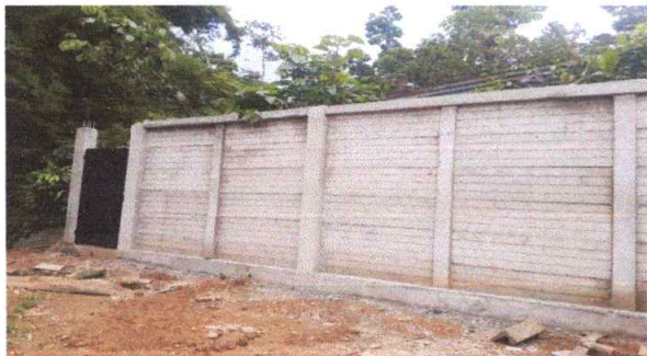
No.1 Mantenimiento correctivo sustitución de circulación de lamina por muro perimetral prefabricado de concreto
