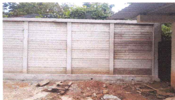
No.2 Mantenimiento correctivo sustitución de circulación de lamina por muro perimetral prefabricado de concreto
