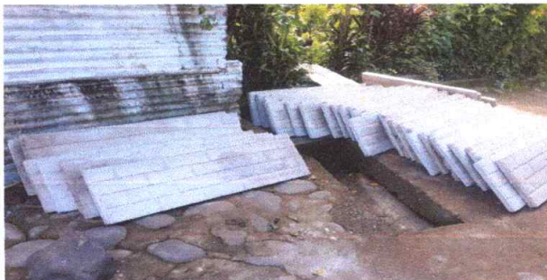
No.5 Mantenimiento correctivo sustitución de circulación de lamina por muro perimetral prefabricado de concreto
