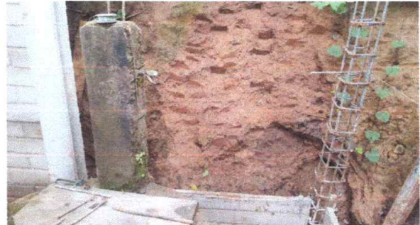
No.4 Mantenimiento correctivo sustitución de circulación de lamina por muro perimetral prefabricado de concreto
