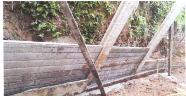
No.6 Mantenimiento correctivo sustitución de circulación de lamina por muro perimetral prefabricado de concreto
