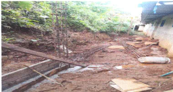
No.3 Mantenimiento correctivo sustitución de circulación de lamina por muro perimetral prefabricado de concreto
