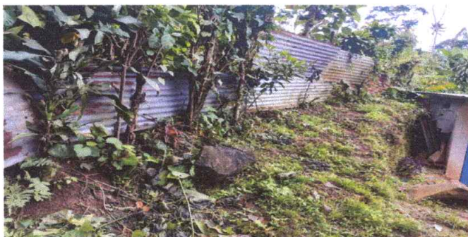
No.3 Mantenimiento correctivo sustitución de circulación de lamina por muro perimetral prefabricado de concreto
