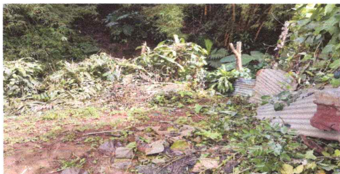
No.1 Mantenimiento correctivo sustitución de circulación de lamina por muro perimetral prefabricado de concreto
