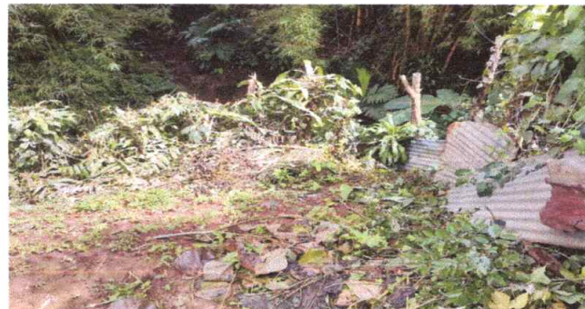
No.2 Mantenimiento correctivo sustitución de circulación de lamina por muro perimetral prefabricado de concreto
