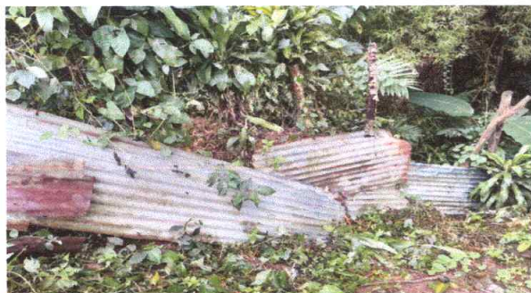
No.5 Mantenimiento correctivo sustitución de circulación de lamina por muro perimetral prefabricado de concreto
