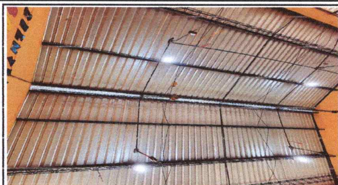
No.2 Sustitución de energía eléctrica con 22 focos de 30 whats + 30 tomacorrientes + 220 metros de cable no 10. Con tubo de pvc + abrazaderas (fase 1 y neutro.)
