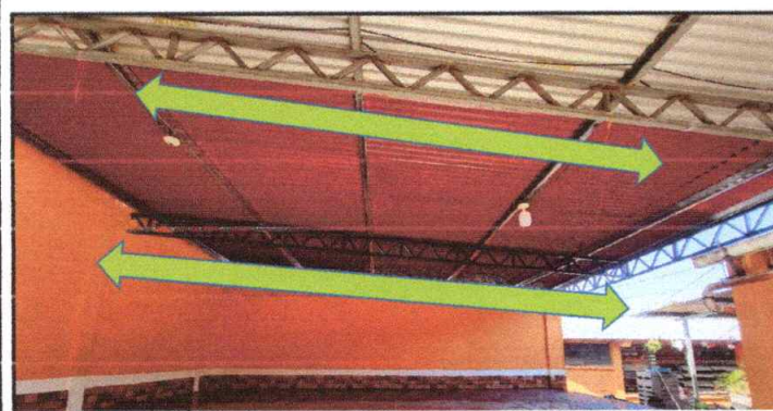
No.5 SUSTITUCIÓN DE ESTRUCTURA METALICA TIPO JOIST CON TUBO CUADRADO DE 2**2" + REFUERZO DE 11/2"X 11/2" GALVANIZADO
