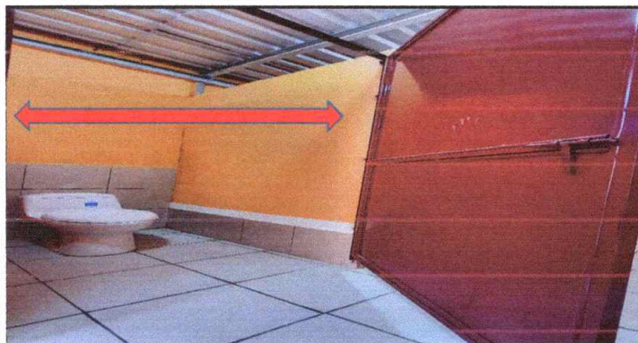
No.3 Mantenimiento correctivo con repello y cernido en muros + pintura en servicios sanitarios
