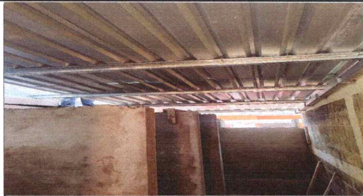
No.1 sustitución de estructura portante de madera por estructura metálica con costanera galvanizada de 3" 2
