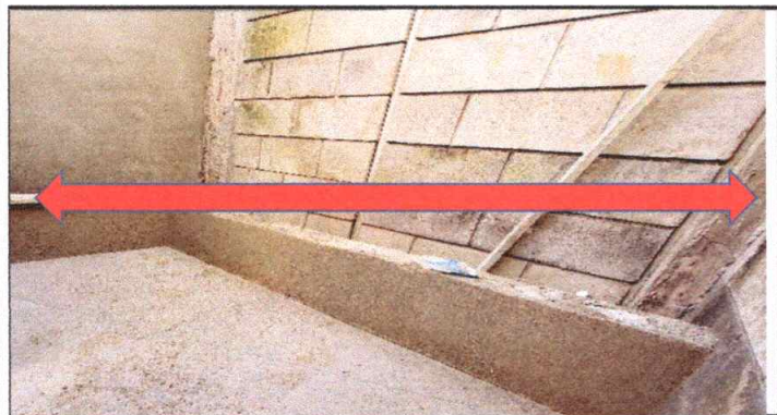
No.3 Mantenimiento correctivo con repello y cernido en muros + pintura en servicios sanitarios
