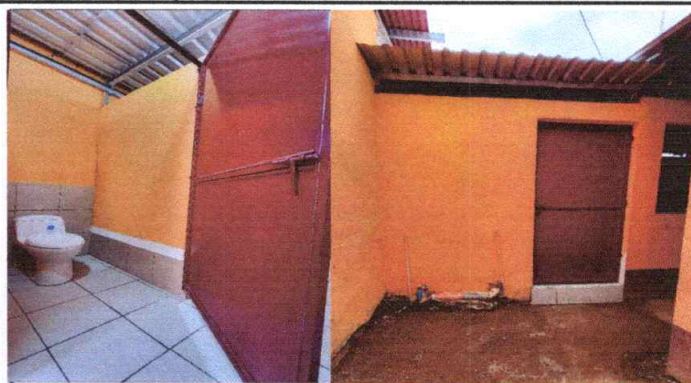
No.2 Sustitución de Puertas de metal
