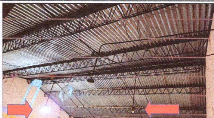
No.2 Sustitución de energía eléctrica con 22 focos de 30 watts + 30 tomacorrientes + 220 metros de cable no 10. Con tubo de pvc + abrazaderas (fase 1 y neutro.)
