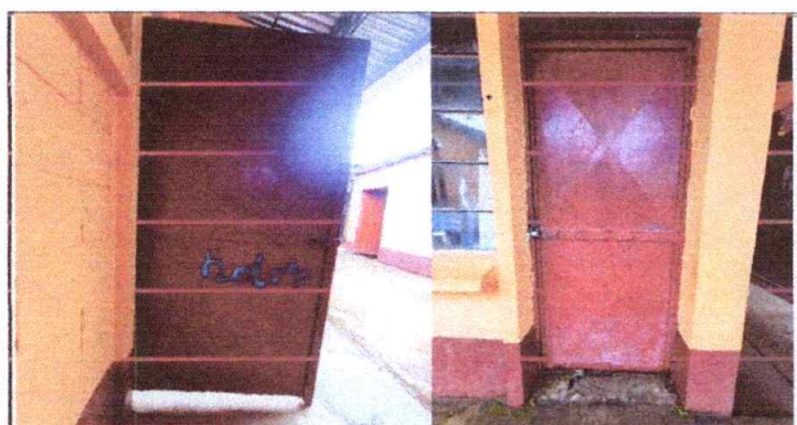
No.3 Reparación de puerta de metal Con tubo cuadrado de 1"1 + lámina 3/64
