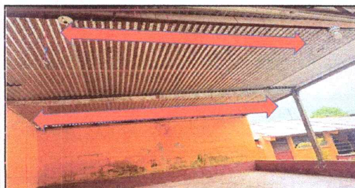
No.5 SUSTITUCIÓN DE ESTRUCTURA METALICA TIPO JOIST CON TUBO CUADRADO DE 2"X2" + REFUERZO DE 1 1/2"X 1 1/2" GALVANIZADO
