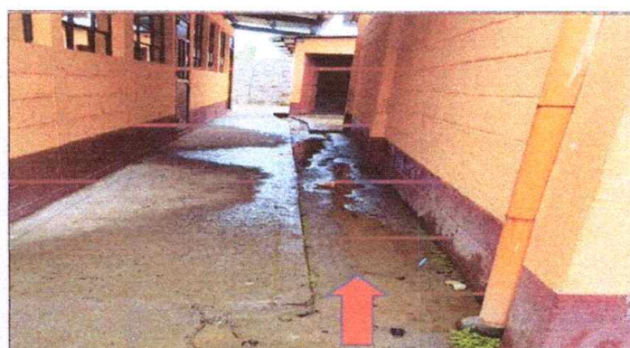
No.4 Reparación de cunetas de desfogue pluvial
