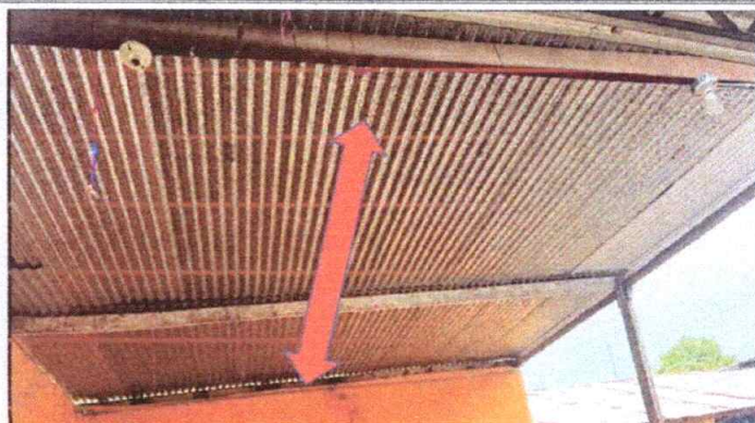
No.2 Mantenimiento preventivo en cubierta metálica de lámina acanalada con pintura anticorrosivo en exterior
