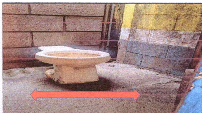
No. 4 Reparación de torta de concreto con azulejo de 30*30
