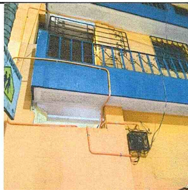
Sustitución de circuito principales a tablero principal.
