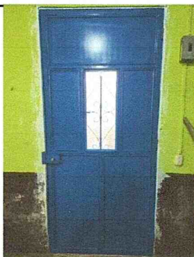
Instalación de puerta de la cocina
