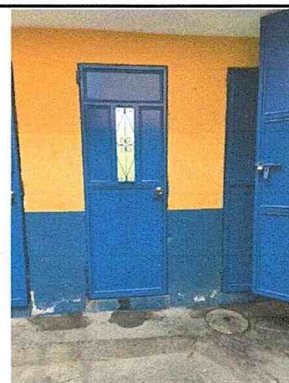
Mantenimiento de puertas de metal baño.
