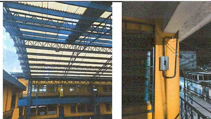
Instalación de lamparas led para exterior instalación de cableado para lampara. No. 10, instalación de tubo eléctrico y accesorio 1/2. Instalación de tablero electrico 1 circuito.
