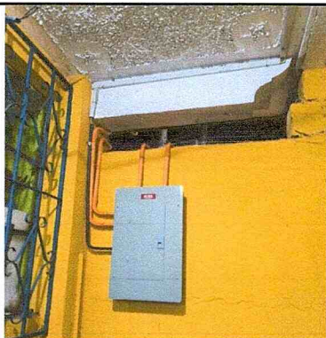
Instalación de tablero electrico 16 circuitos, plifones para tablero eléctrico.
