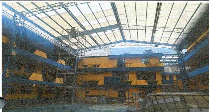
Instalación de lamparas led para exterior instalación de cableado para lampara. No. 10, instalación de tubo eléctrico y accesorio 1/2. Instalación de tablero electrico 1 circuito.
