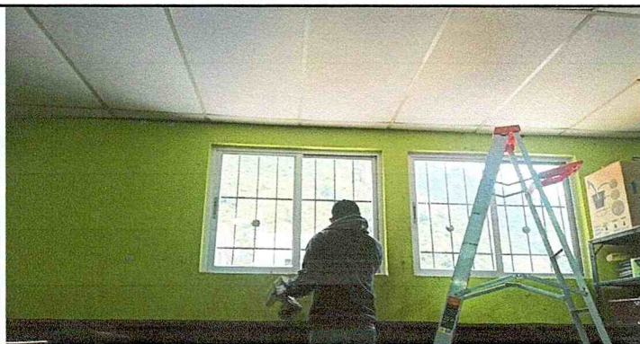
Sustitución de ventanas de aluminio corredizas
