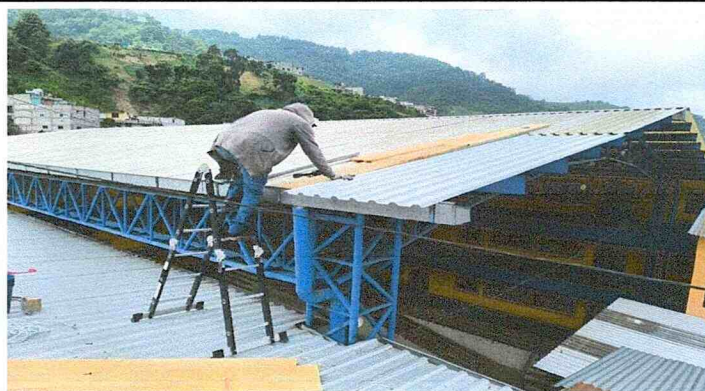
Sustitución de lámina troquelada calibre 26, sustitución de lámina policarbonato troquelada.
