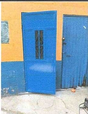
Instalación de puerta de metal baño
