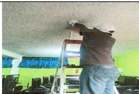
Sustitución de bombillas led, sustitución de plafoneras, instalación de canaletas y cableado de plafonera.
