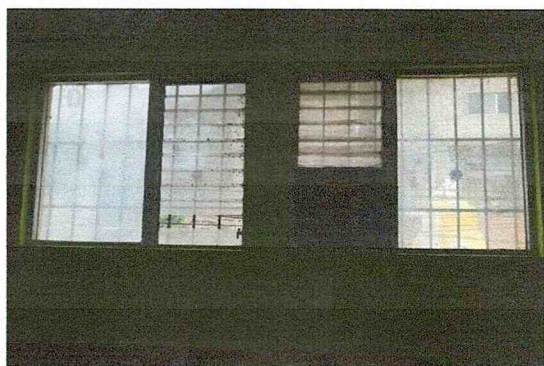
Sustitución de ventanas de aluminio corredizas.
