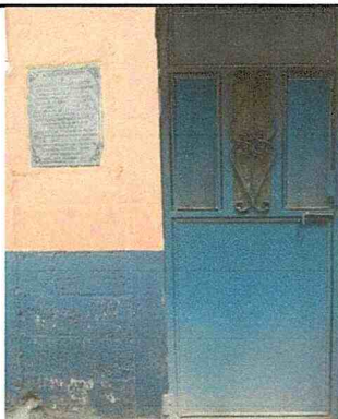
Instalación de puerta de metal baño.
