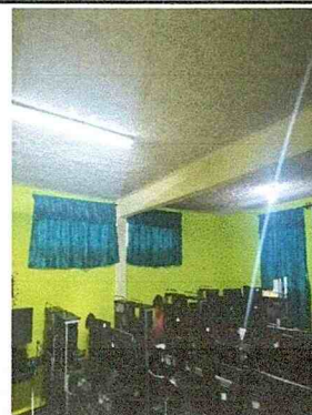
Sustitución de bombillas led, sustitución de plafoneras, instalación de canaletas y cableado de plafonera.
