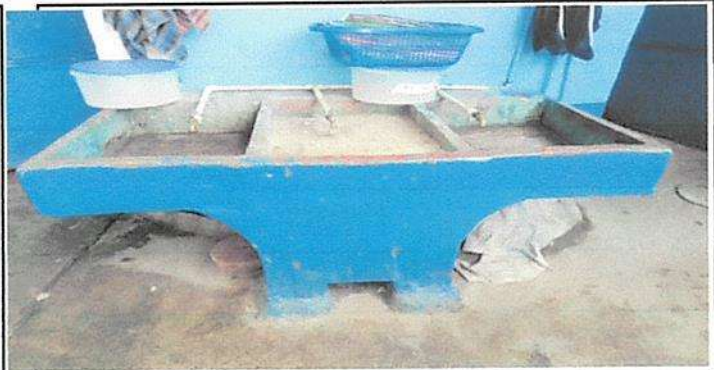
Repáracion de baterias de labamano. 1o. Nivel
