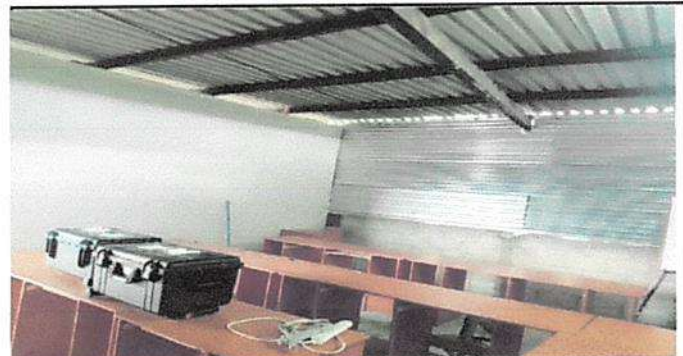
Reparación de cielo falso en el aula y reparacion electrica Tercer Nivel.
