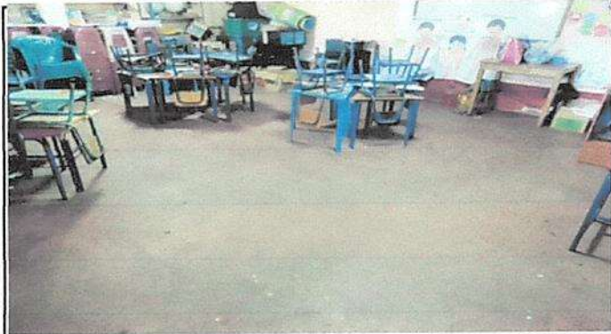
Sustitucion de piso de concretao a piso ceramico en el aula. 1o. 2o. Y 3o. Nivel
