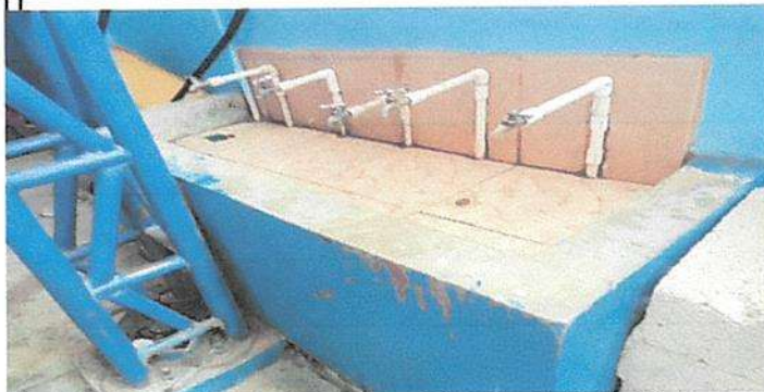
Sustitucion o reparacion de tubo pvc a tubo galvanizado. 1o. Nivel
