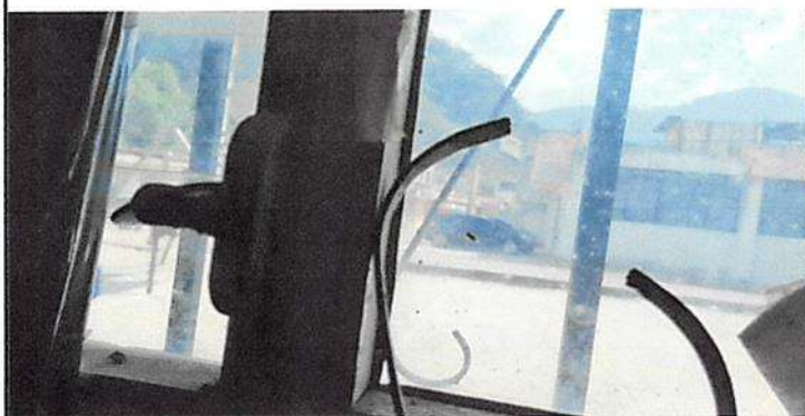
Sustitucion de tres operadores (tipo mariposa) en ventanas tipo paleta
