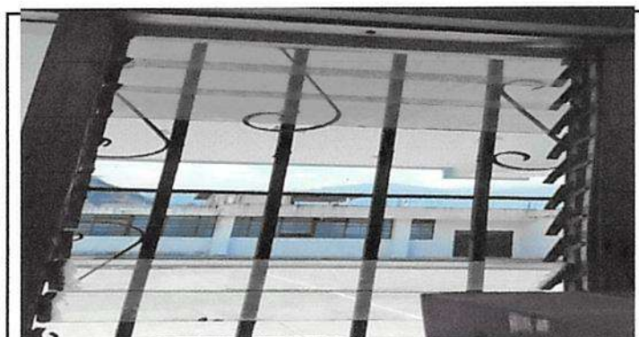
Sustitucion de vidrios de 5 mm en ventanas, primer y segundo nivel
