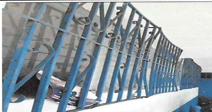
Sustitución de balcones en modulo 1 primer nivel
