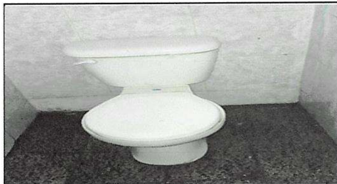
Sustitución de inodoro elongado en servicio sanitario, modulo 1 primer nivel
