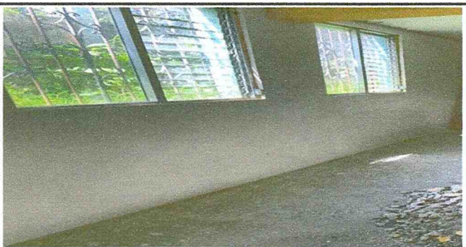
Foto 3: Sustitución de repello más cernido en pared
