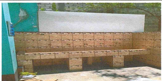
Foto 5: Remozamiento de lavamanos incluye instalación de azzulejos, instalaciones de azulejo instalación de 6 chorros.
