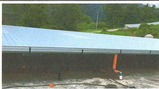
Foto 2: Sustitución de canal de metal y bajada pluvial
