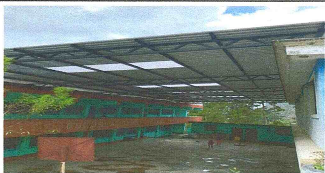
Foto 1: Reparación de estructura metálica para cancha
