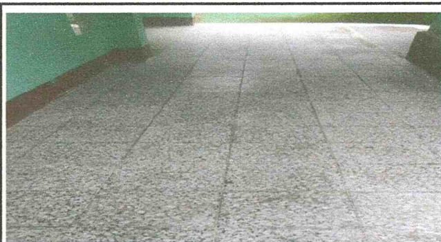
Foto 4: Reparación de piso de pasillo a piso de granito de marmol
