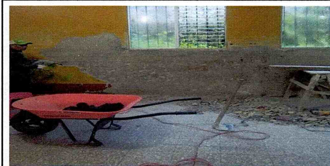
Foto 3: Inicio de Sustitución de repello mas cernido de pared
