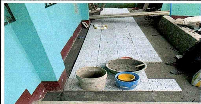
Foto 4: Inicio de reparación de piso de pasillo
