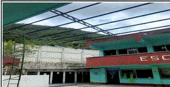
Foto1: Inicio de reparación de estructura metálica para cancha
