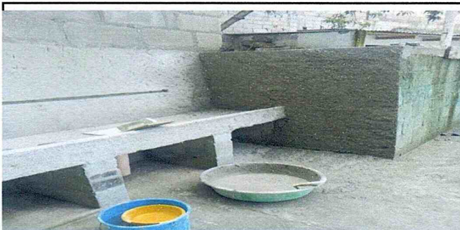
Foto 5: Inicio de remozamiento de lavamanos incluyendo instalación de azulejo, instalación de chorros
