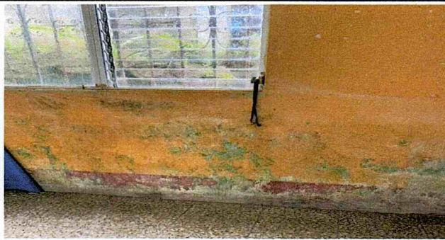
Sustitución de repello más cernido en pared
