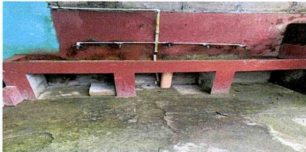
Remozamiento de lavamanos incluye instalación de azulejo, instalación de chorros
