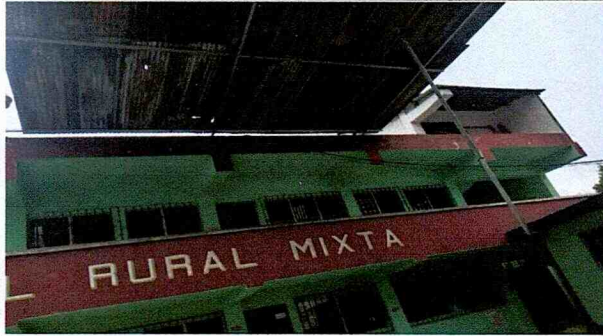
Reparación de estructura metálica para cancha
