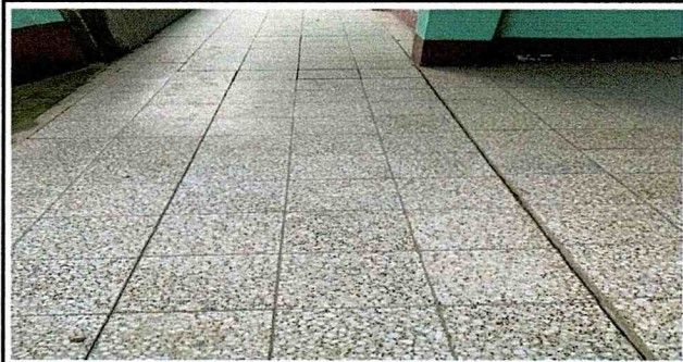
Reparación de piso de pasillo
