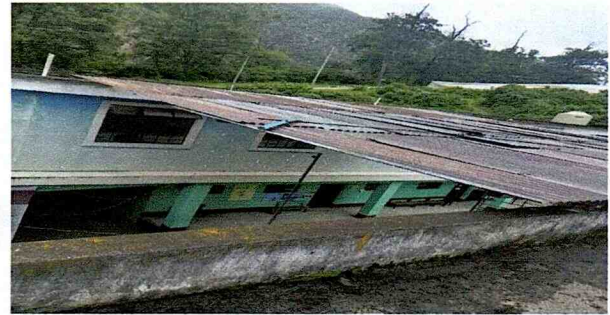
Sustitución de canal de metal y bajada pluvial
