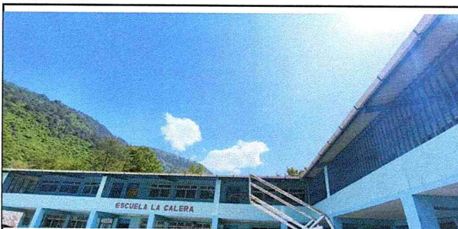
Foto 10: Instalación canal Pvc para agua pluvial con bajada de agua pluvial + mas pescantes de metal a cada 1m
