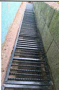
Foto 5: Sustitución de rejilla de drenaje pluvial (0.32m x11m) + aplicación de pintura anticorrosivo color negro.
