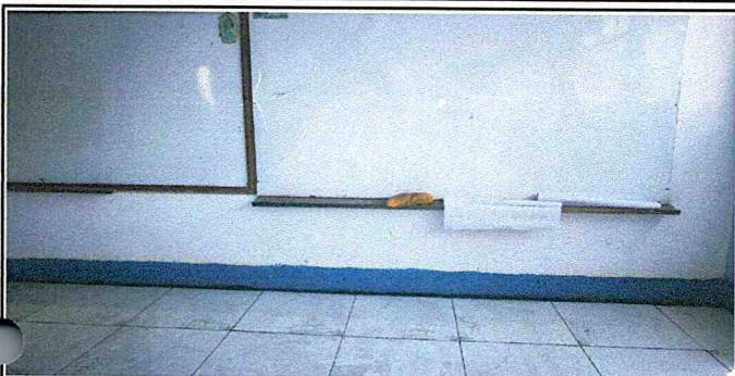
Foto 7: suministro y aplicación pintura en zócalo de interior de dos aula azul pantone 293 (dos manos).
