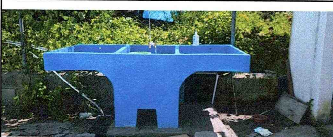
Foto 12: sustitución de pila de 2 lavaderos color azul (1m x 1.90m) + fundición de base + sustitución de 2 chorros
