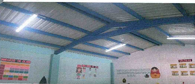
Foto 11: Suministro y aplicación de pintura color blanco y color celeste en faldón de tabla yeso en 5 aulas (dos manos)
