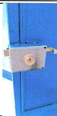
Foto 8: Sustitución de chapa de puertas
