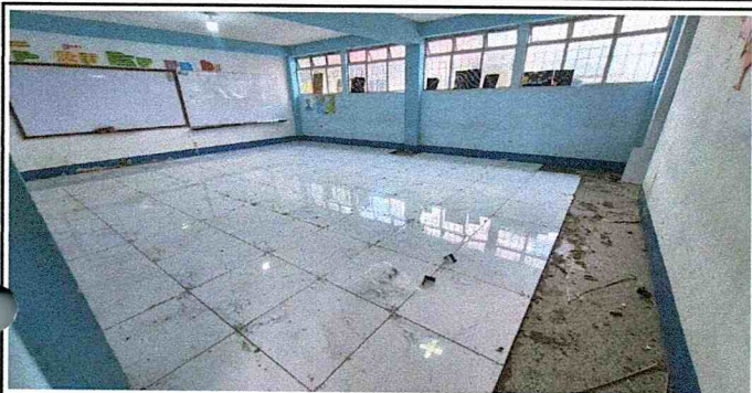
Foto1: Sustitución de pisos porcelanato en dos aulas.
