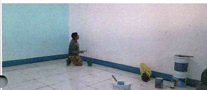
Foto 7: Suministro y aplicación pintura en zócalo de interior de aula azul pantone 293
