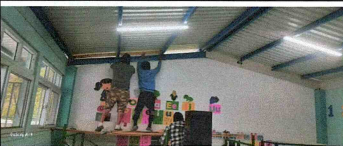
Foto 9: Instalación faldón de tabla yeso en techo en 5 aulas
