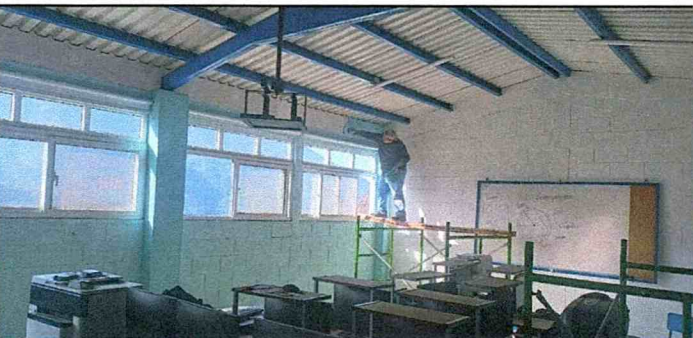
Foto 11: Suministro y aplicación de pintura en faldón de tabla yeso (5 aulas)
