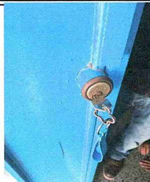
Foto 8: Sustitución de chapa de puertas
