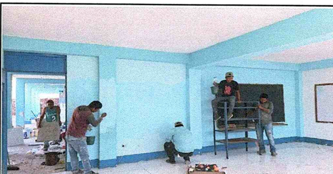
Foto 6: Suministro y aplicación de pintura en paredes de interior de aula celeste pantone 293
