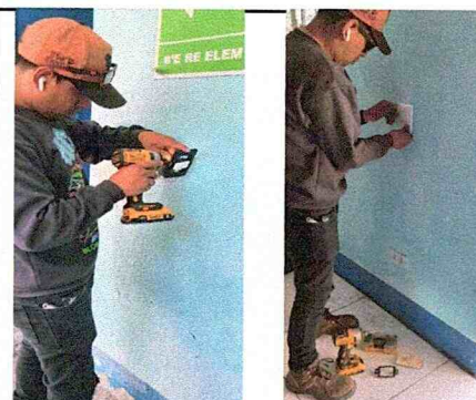
Foto 4: Sustitución de interruptor para lamparas
