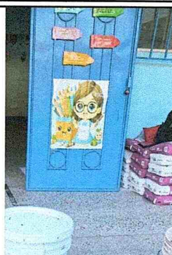
Foto 2: Mantenimiento de puerta de metal (ajuste + pintura)
