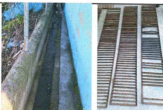
Foto 5: Sustitución de rejilla de drenaje pluvial
