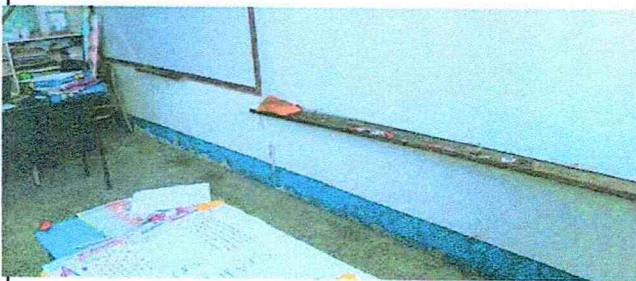
Foto 7: Suministro y aplicación pintura en zócalo de interior de aula azul pantone 293.
