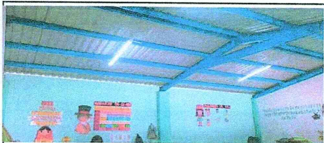
Foto 11: Suministro y aplicación de pintura en faldón de tabla yeso (5 aulas).
