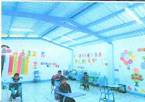
Foto 9: Instalación faldón de tabla yeso en techo en 5 aulas.
