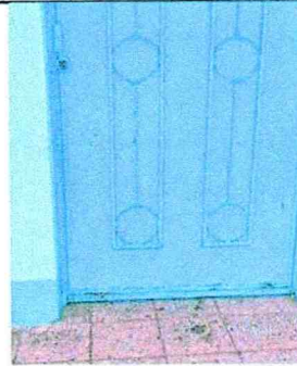
Foto 2: Mantenimiento de puerta de metal (ajusto + pintura)
