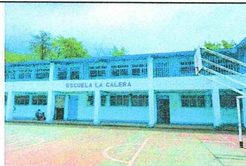
Foto 10: Instalación canal Pvc para agua pluvial con bajada de agua pluvial.
