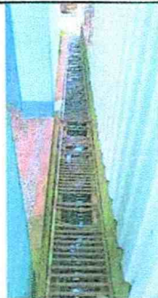
Foto 5: Sustitución de rejilla de drenaje pluvial
