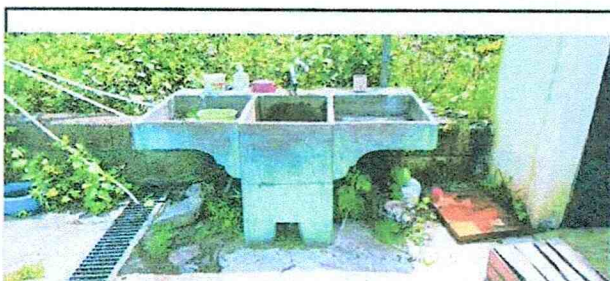
Foto 12: Sustitución de pila de 2 lavaderos .
