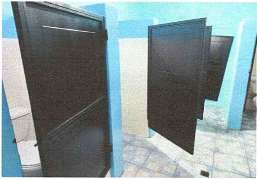
Foto 3: Mantenimiento y estructura puerta de metal baños
