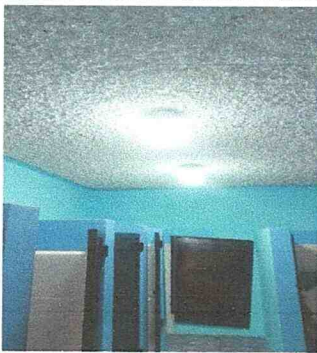
Foto 12: Sustitución de lamprás existentes.
