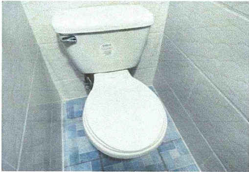
Foto1: Sustrucción inodoro elongado.
