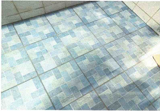
Foto 5: Sustrucción de piso cerámico antideslizante.
