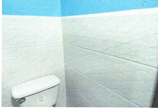
Foto 4: Sustrucción de azulejo
