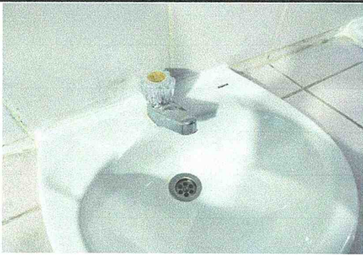
Foto 8: Sustitución de mezcladora lavamanos.
