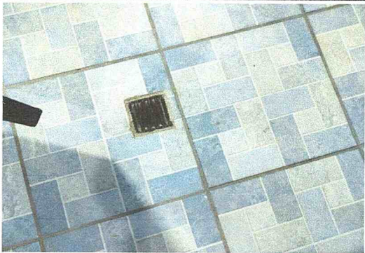
Foto 11: Mantenimiento de drenaje y agua potable.
