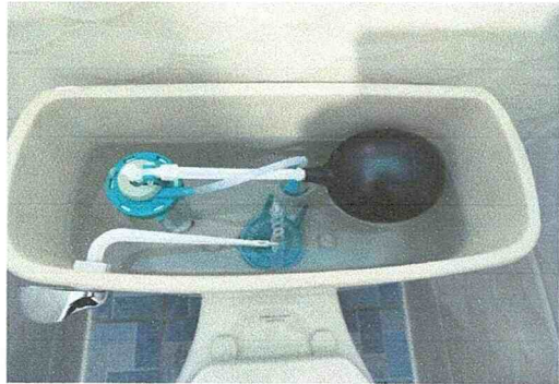
Foto 2: Sustrucción de accesorios de inodoro
