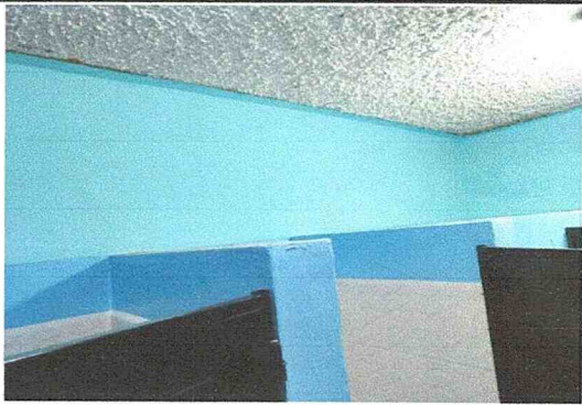
Foto 9: Suministro y aplicación pintura interior pantone Celeste 293 lavable
