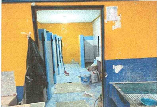
Foto 3: Mantenimiento y estructura puerta de metal baños
