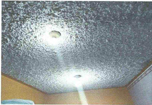
Foto 12: Sustitución de lamprps existentes.
