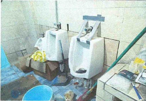
Foto 6: Sustrucción de mingitorio
