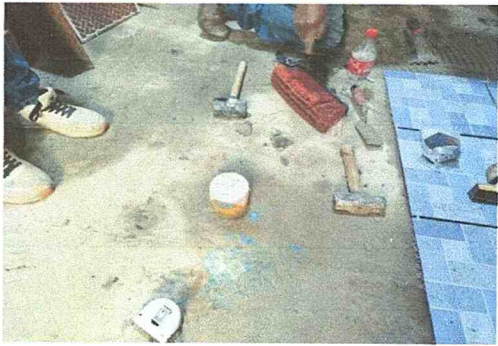
Foto 11: Mantenimiento de drenaje y agua potable.
