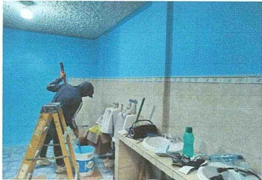
Foto 9: Suministro y aplicación pintura interior pantone Celeste 293 lavable
