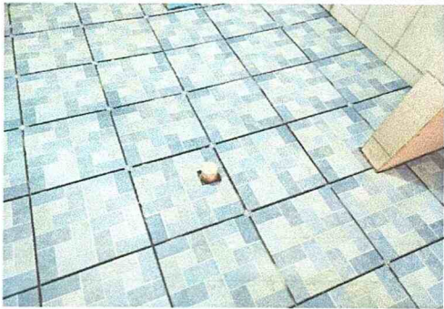
Foto 5: Sustrucción de piso cerámico antideslizante.
