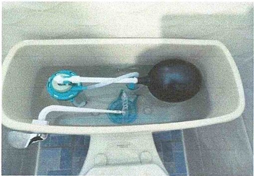
Foto 2: Sustrucción de accesorios de inodoro
