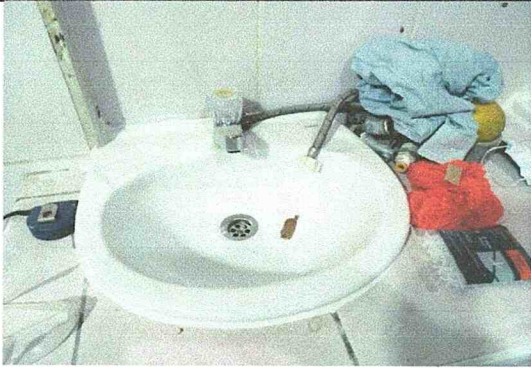
Foto 8: Sustitución de mezcladora lavamanos.
