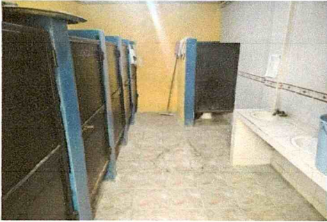
Foto 5: Sustitución de piso cerámico antideslizante
