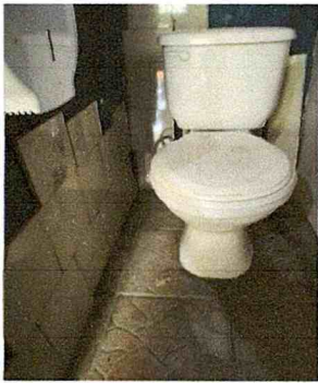
Foto 4: Sustitución de azulejo
