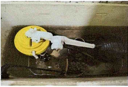
Foto 2: Sustitución de accesorios de inodoro
