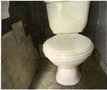
Foto 1: Sustitución inodoro elongado
