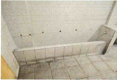
Foto 6: Sustitución de mingitorio
