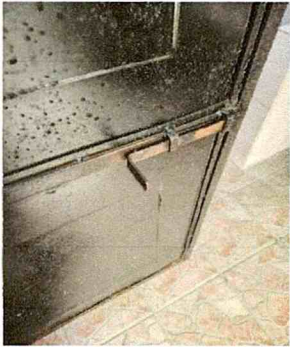
Foto 3: Mantenimiento a estructura puerta de metal baños
