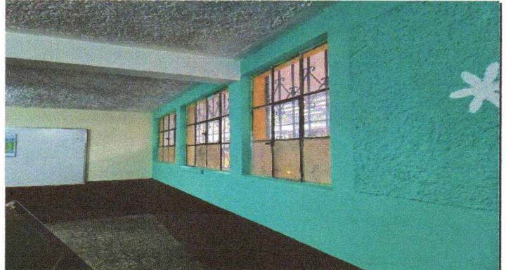
SUMINISTRO Y APLICACIÓN DE PINTURA PARA 17 AULAS PAREDES CON ZOCALO PINTURA DE ACEITE (MODULO A Y B) 1220 m2
