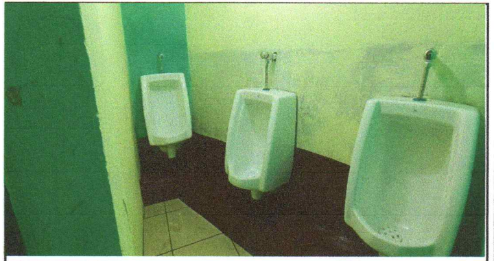
SUSTITUCIÓN DE MINGITORIO A MINGITORIO PUSH, COLOR BLANCO (DESMONTAJE, DRENAJE DE PVC). EN (MODULO SERVICIO SANITARIO) 3 unidades.
