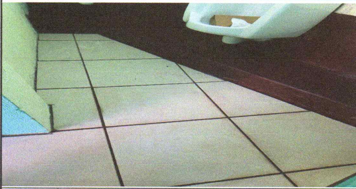
INSTALACIÓN DE PISO CERAMICO EN 1 BAÑO. 2 unidades
