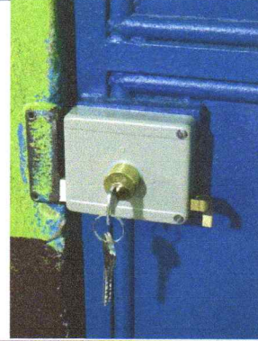
SUSTITUCIÓN DE CHAPA YALE EN PUERTA DE METAL (INCLUYE DESMONTAJE DE ANTIGUA) 1 unidad.
