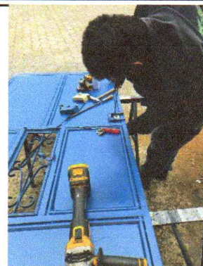
SUSTITUCIÓN DE CHAPA YALE EN PUERTA DE METAL (INCLUYE DESMONTAJE DE ANTIGUA) 1 unidad.
